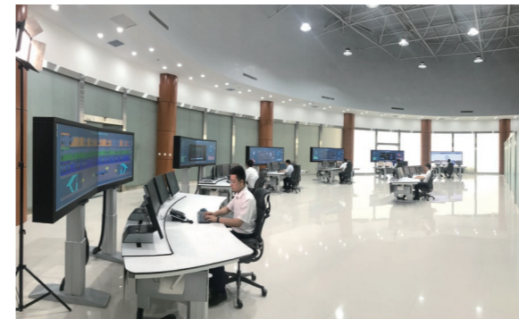
陕煤小保当矿综合自动化项目
